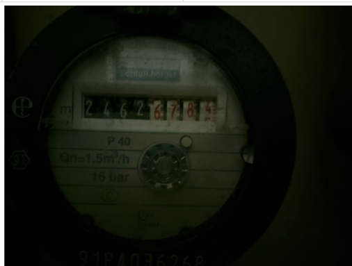
Compteur eau froide
