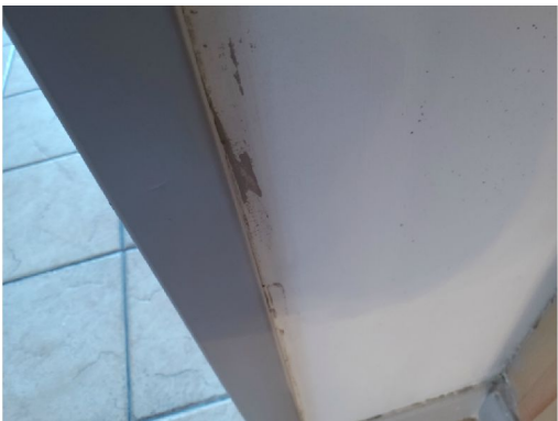
Mur de droite
